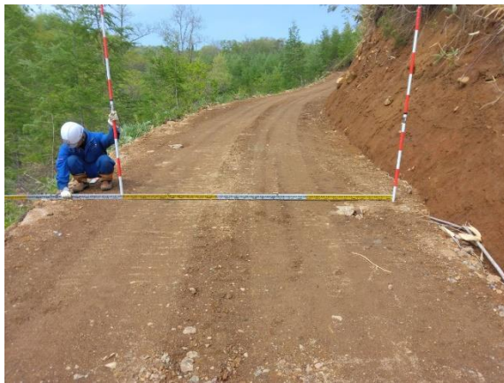
〈勾配緩和の様子〉
