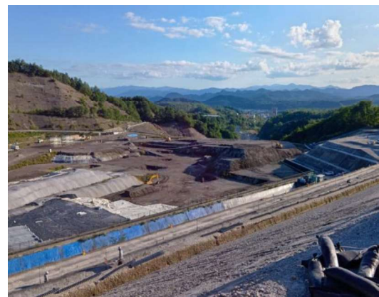
〈最終処分場拡張工事〉
