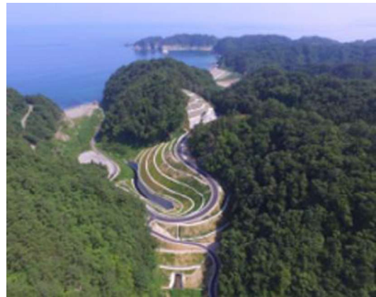
〈道路災害復旧工事〉
